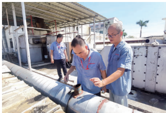
变压器车间检查抽风管道使用状况
