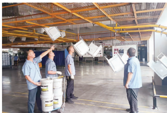
定期检查维护喷涂腔体输送链驱动器
