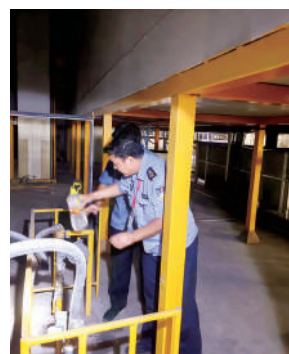
检查燃气管道
